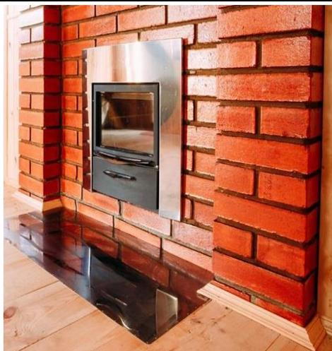
Для отвода дыма следует применять вертикальные дымовые трубы без уступов, в местах пересечения которых со сгораемыми конструкциями расстояние от внутренней поверхности дымовых каналов до этих конструкций должно быть не менее 38 сантиметров. Для защиты пола перед топкой печи следует предусмотреть металлический лист размером 70 на 50 сантиметров.
